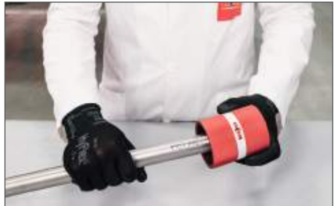
Sbavatura del tubo / Deburring the pipe
